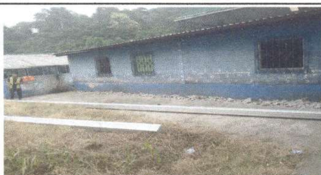
Foto 3: Sustrucción de canal de metal modulo No. 4
