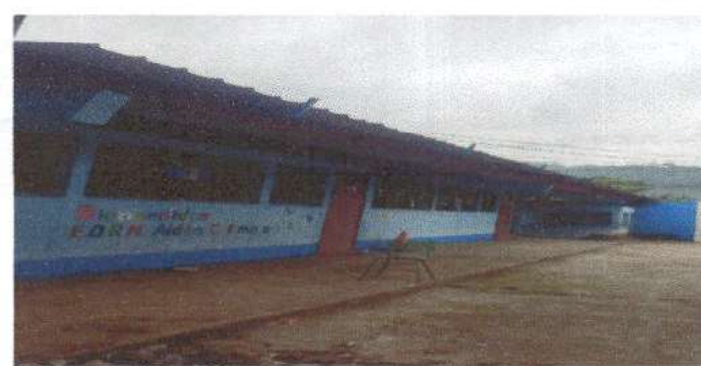
Foto 6: Sustrucción de canal de metal modulo No. 1
