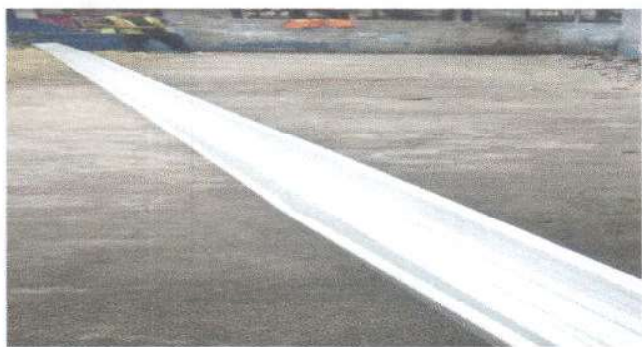
Foto 1: Sustrucción de canal de metal cancha polideportiva.
