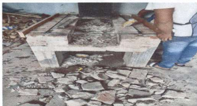
Foto 2: Sustrucción de plancha de metal de tres ornillas, mantenimiento estufa rural.
